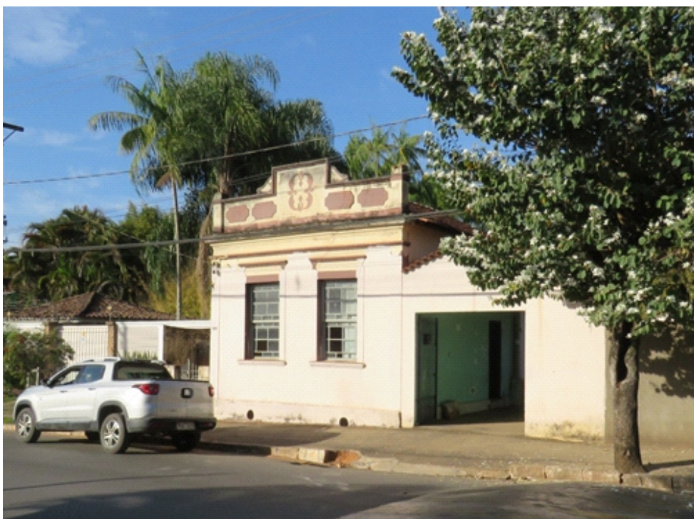
Fachada do escritório da ARPA Rio Grande em Jacutinga/MG antes da reforma. Agosto/2018.
